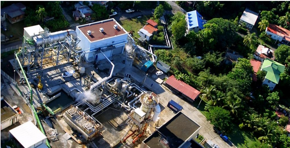
Fig 2: Centrale de Bouillante en Guadeloupe
