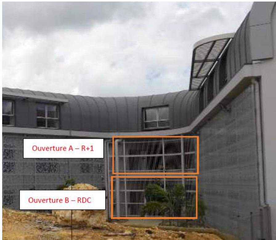
Vue extérieure des circulations inter-bâtiments (ouvertes au RDC et R+1 – fermées au R+2)
